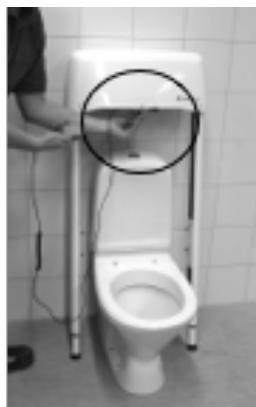
2. Plasser heisen over toalettstolen. Koble til håndkontrollen under toppdekselet. Slå på strømbryteren under toppdekselet
