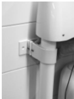
5. Juster inn de øvre veggfestene på 950 mm fra gulvet, marker, bor, plugg og skru til.
