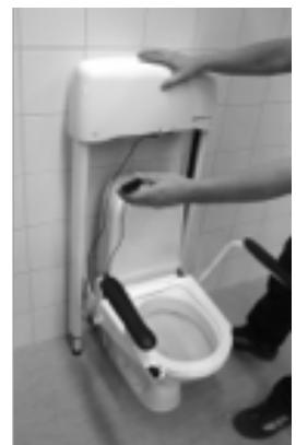
4. Centrer liften, så begge huller i bagkanten af sædepladen havner lige over toilletets to huller.
